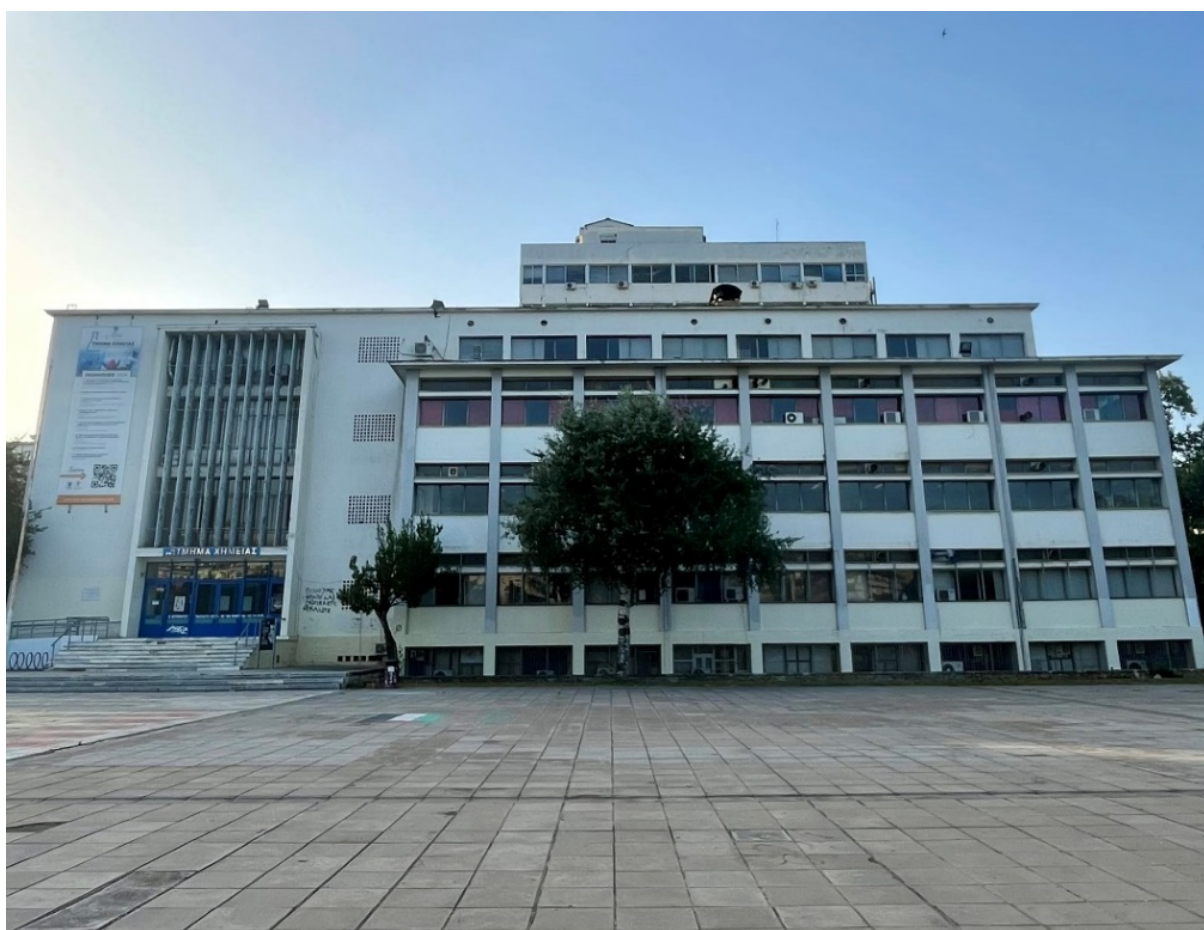
Κτιριακές εγκαταστάσεις του Τμήματος Χημείας, Παλαιό Χημείο
