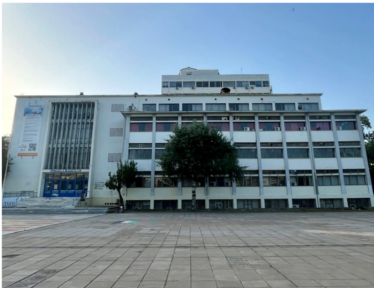
Κτιριακές εγκαταστάσεις του Τμήματος Χημείας, Παλαιό Χημείο
